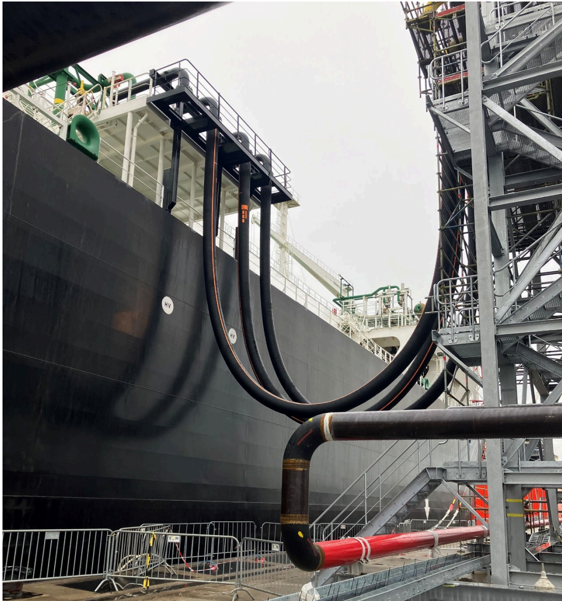
29. ábra Földgáz szállító tömlők az LNG újra gázosító hajó és a kikötői gáz fogadó állomás között, felszerelés közben (NA300, PN=120 bar, 30 m, API 17K)
