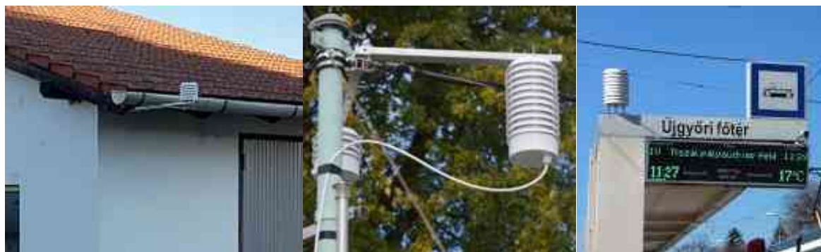
33. ábra Homlokzatok, oszlopok és megállók rögzítési módjai
