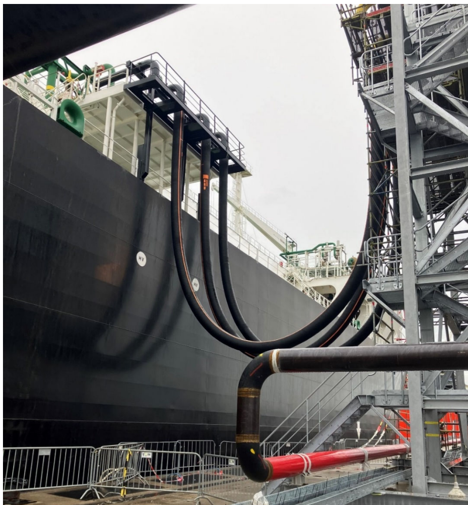
11. ábra Földgáz szállító tömlők az LNG újra gázosító hajó és a kikötői gáz fogadó állomás között, felszerelés közben (NA300, PN=120 bar, 30 m, API 17K)
