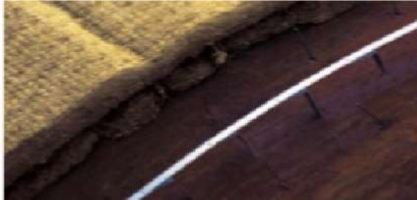
15.ábra Paplanok átfedett elhelyezése nagyméretű hengeres tartályon.[5]
