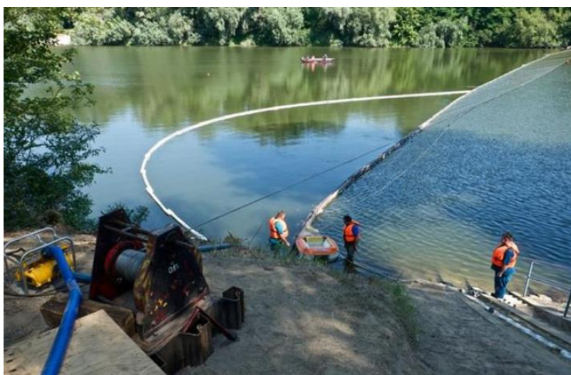
31. ábra Kétsoros, vezérköteles "T" merülőfalból készült elzárás olajscapdával
