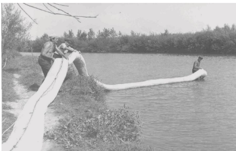
30. ábra Adszorbenssel töltött hurka vízre helyezése kisvízfolyáson
