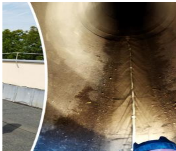
49. ábra: Csapadék mérés (tető, csatorna) Forrás: LIFE Városi Eső
