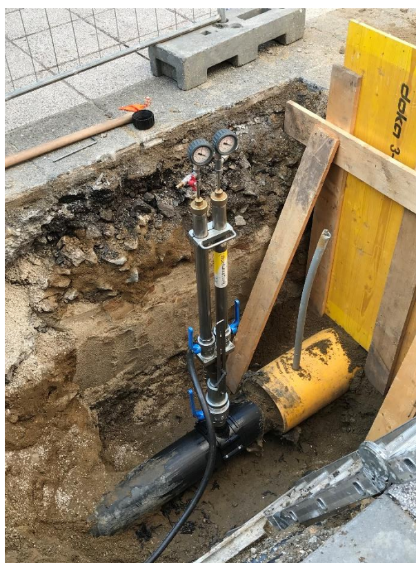
1. ábra Eger belvárosában végzett szakaszolás dupla ballonozó szerkezettel Forrás: A szerző saját készítése
